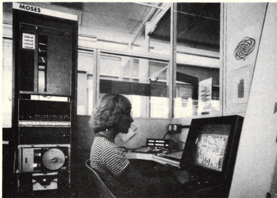
Afb. 1. Ontwerpen van complexe halfgeleiderstructuren m.b.v. een computersysteem, het zgn. CAD (computer aided design).
